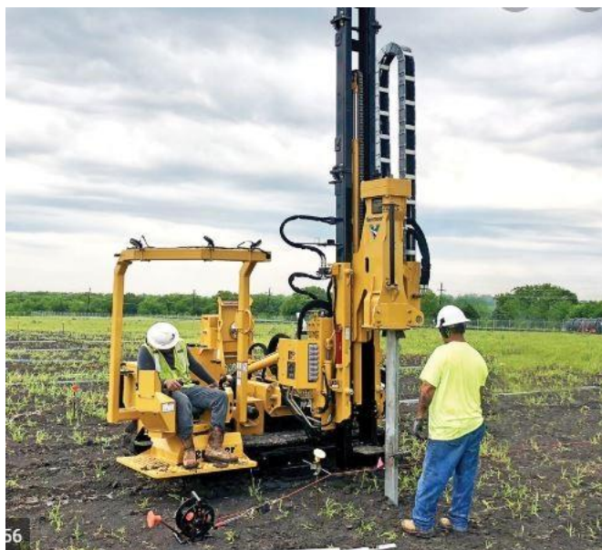
Figur 3. Pålning av stålprofiler. Källa: LC Energi
