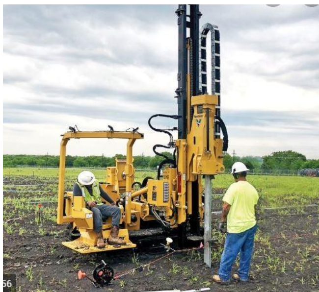
Figur 3. Pålning av stålprofiler. Källa: LC Energi.
