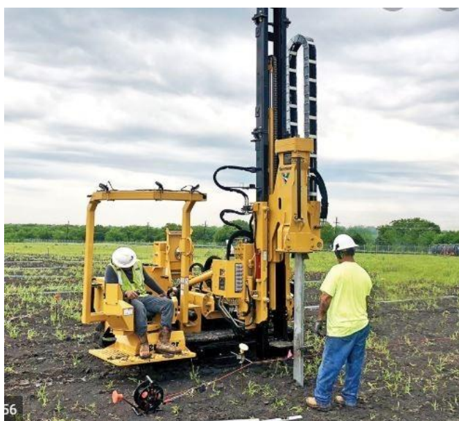
Figur 3. Pålning av stålprofiler. Källa: LC Energi.
