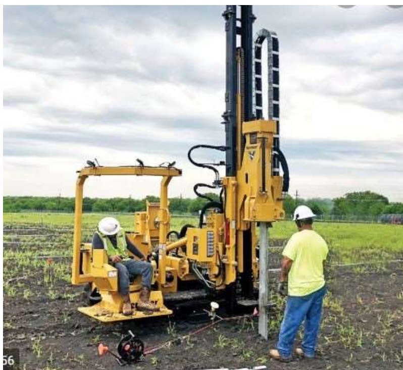
Figur 12. Pålning av stålprofiler (LC Energi, Platsbesök solpark Holland, 2023)
