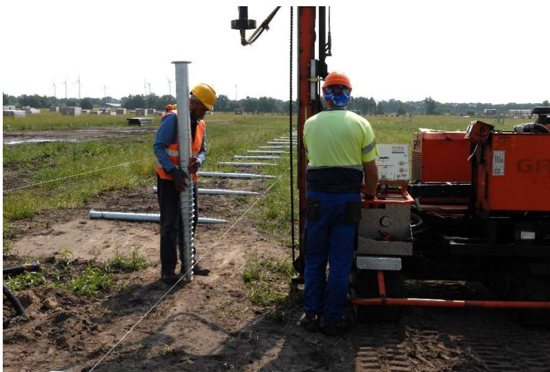
Figur 13. Markskruvmaskin (LC Energi, Platsbesök solpark Holland, 2023).
