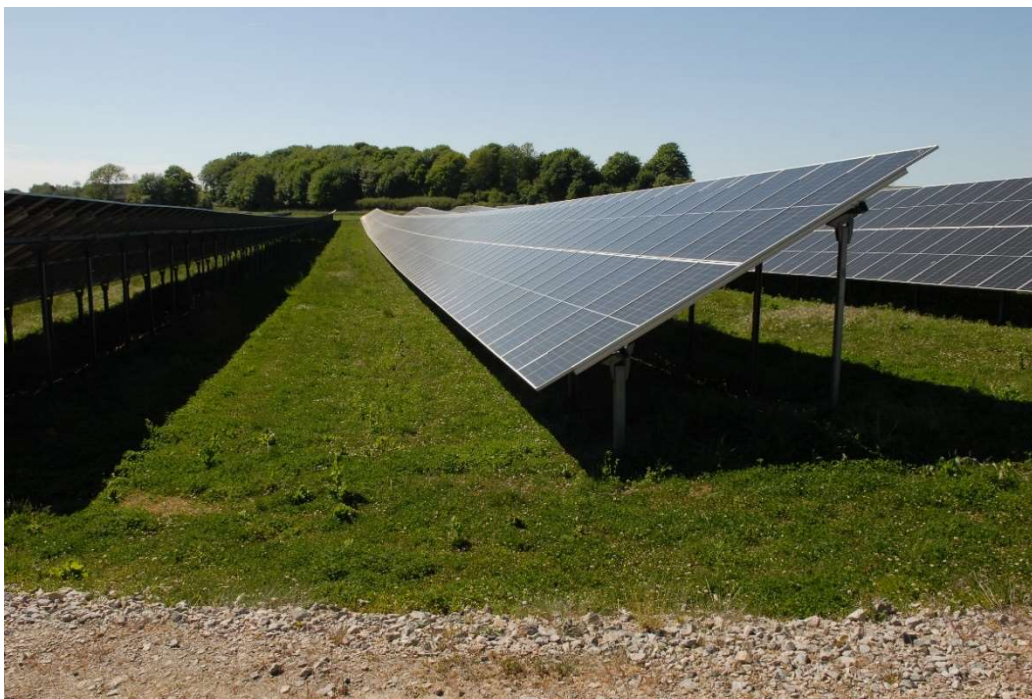
Figur 10. Solceller på stativ med fast lutning (LC Energi).
