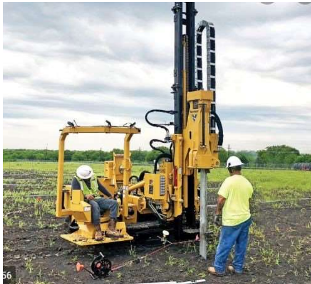
Figur 3. Pålning av stålprofiler.
